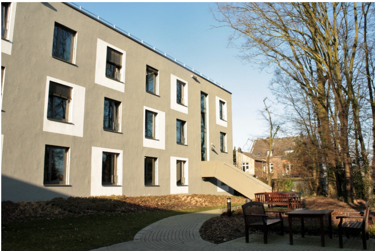
St. Irmgardis Krankenhaus Neubau
